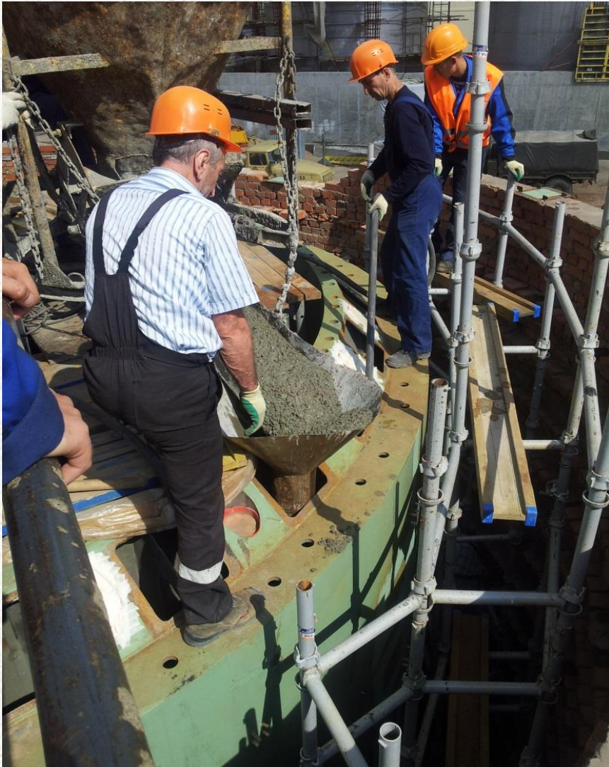
Бетонирование блока «С3»
