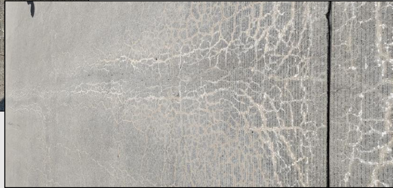
Щелочная коррозия заполнителя
