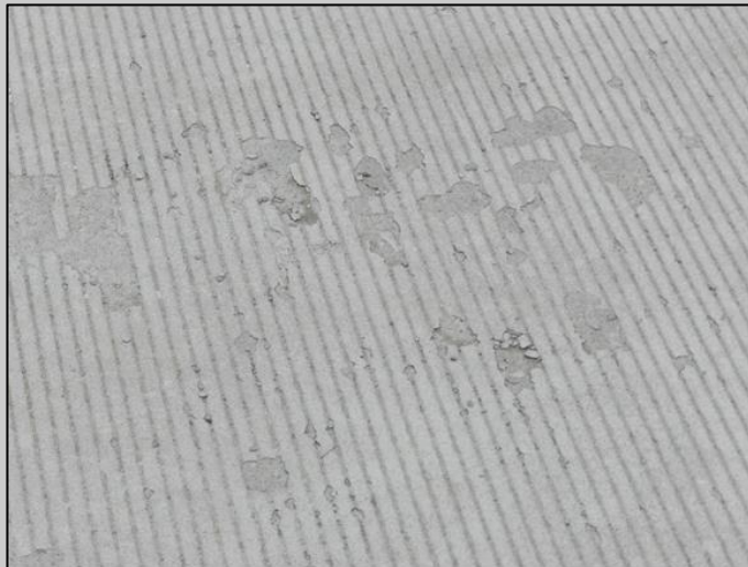
Шелушение бетона
