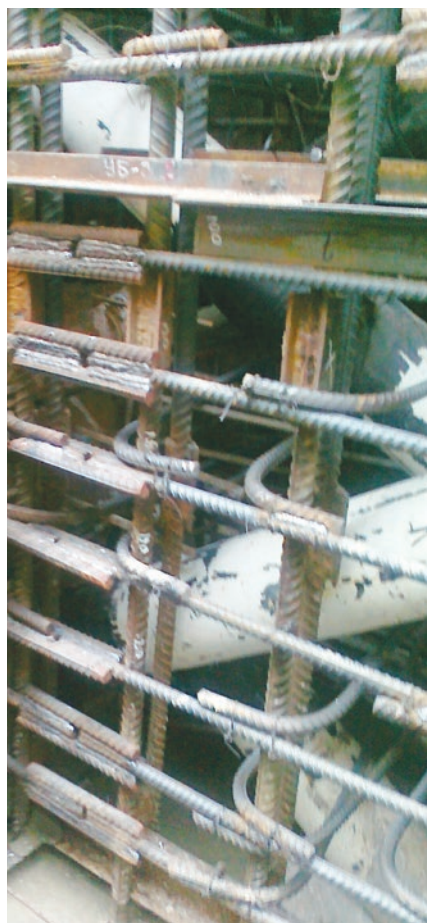
Рис. 1. Армирование блока В30 с установленными каналообразователями
