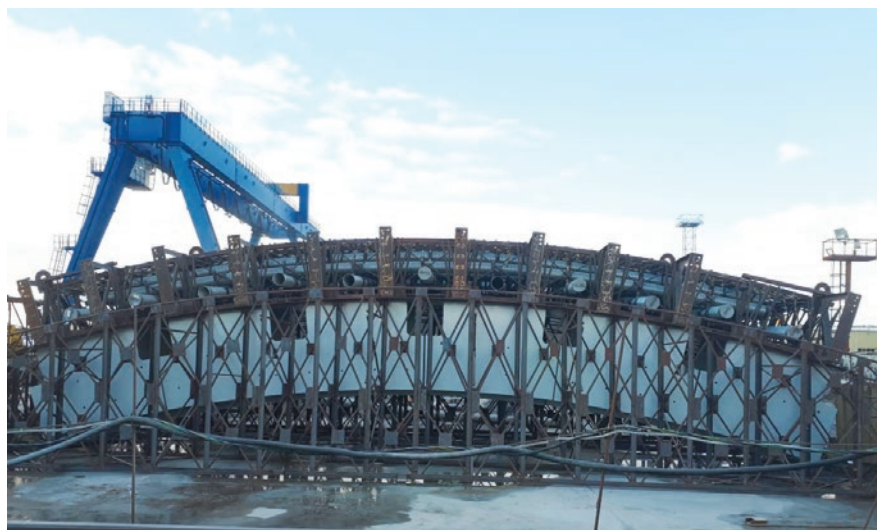
Рис. 2. Объемный блок В30 готовый к монтажу
