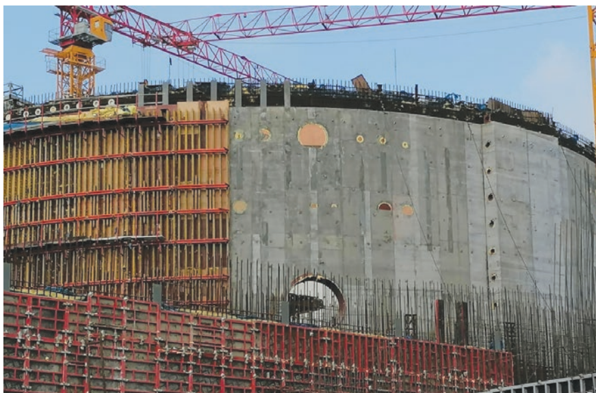
Рис. 6. Снятие опалубки яруса ВЗО
