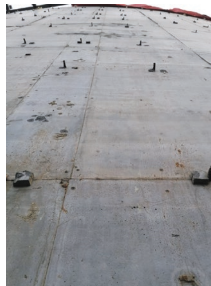
Рис. 7. Поверхность конструкции ВЗО после распалубки
