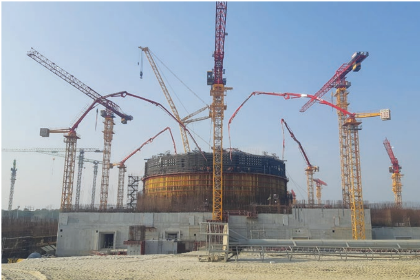
Рис. 4. Бетонирование яруса В30
